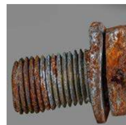
Corrosão em roscas
